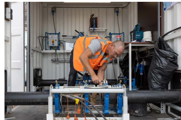
De mobiele lascontainer, waar aan de éne kant de PE-buis in gaat en aan de andere kant eruit. Binnen, onder geconditioneerde omstandigheden, wordt de las gemaakt.
