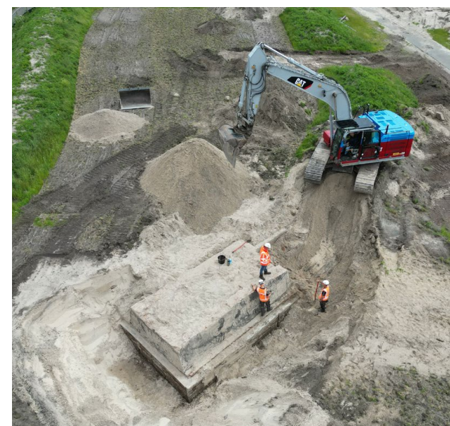
Eén van de 14 betonnen bunkers uit de Tweede Wereldoorlog die door Markus is verwijderd.
