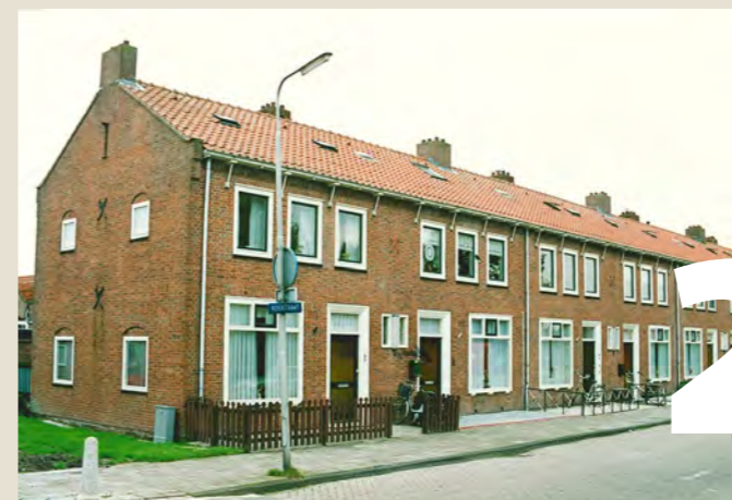
▼ In 2002 werden 20 duplexwoningen uit 1950 aan de Roerstraat gesloopt, om in 2005 plaats te maken voor nieuwbouw: 24 woningen, verdeeld over twee woonlagen.
