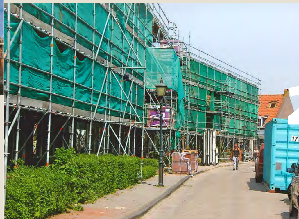
◀ De grondige renovatie van 25 eengezinswoningen in de Boegstraat in 2011, waarbij met name al het metselwerk van voor- en achtergevels werd vervangen.
